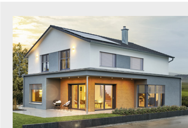
Foto: Fertighaus WEISS
